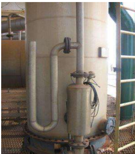
Figura 10 – Proteção contra vácuo utilizando um sifão
