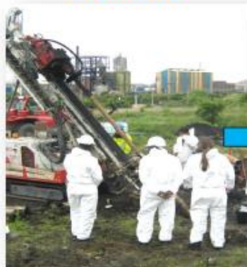
Perfuração de um poço inclinado
